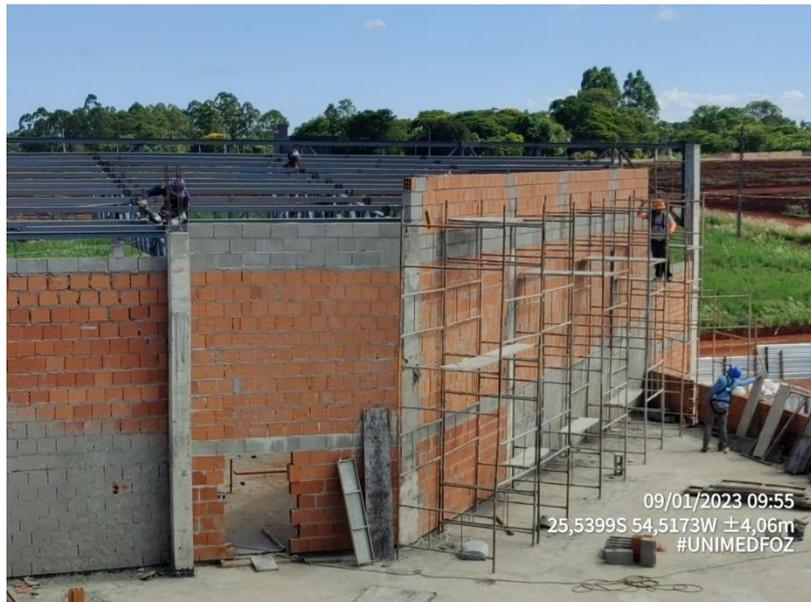
**Foto 26 – Alvenaria – Levante – Fachada Principal**
