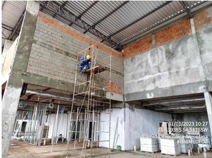
Foto 29 – Alvenaria – Levante – Fachada Principal
