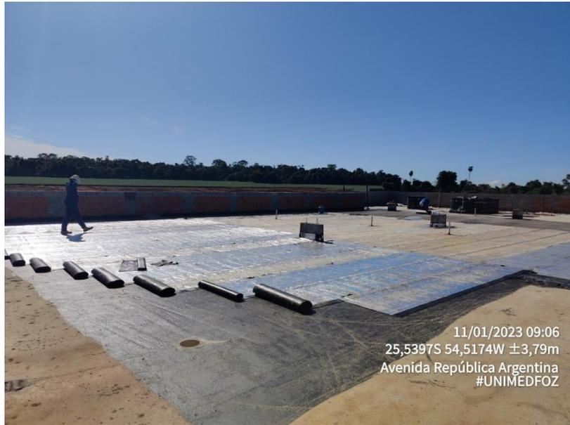
**Foto 17 – Impermeabilização – Cobertura – Manta Aluminizada**
