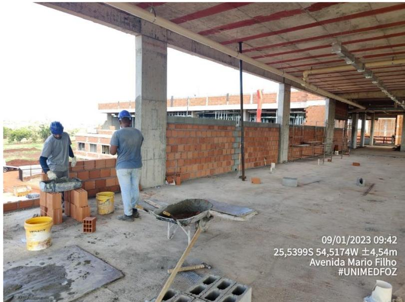
Foto 30 – Alvenaria – Levante – Fachada Principal
