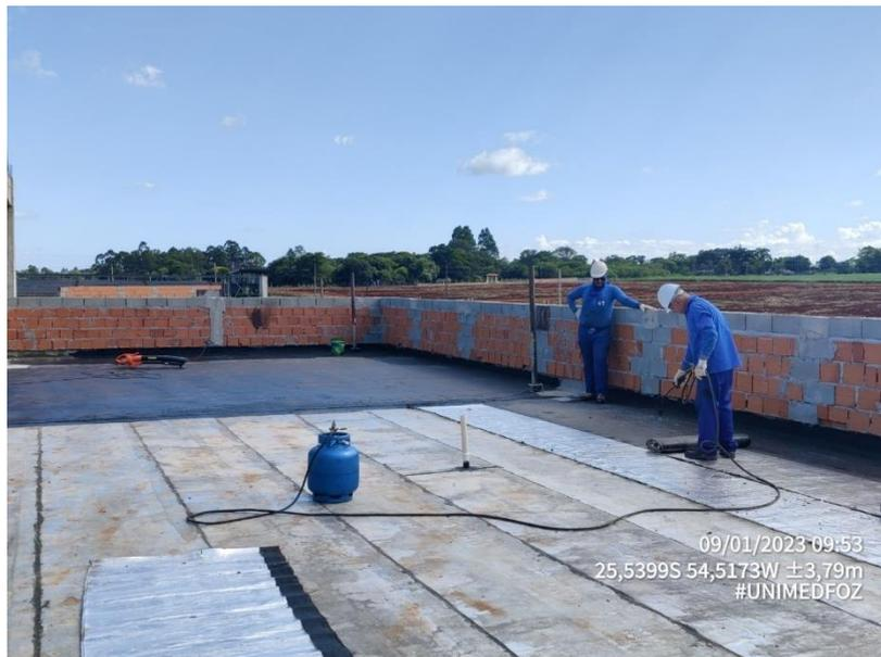
**Foto 16 – Impermeabilização – Cobertura – Manta Aluminizada**
