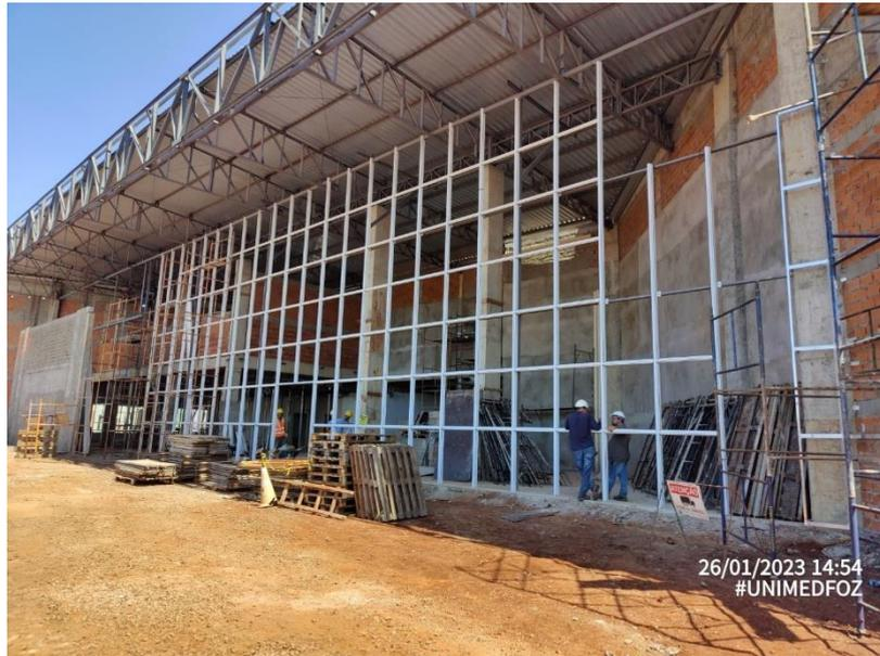
**Foto 5** – Estrutura Metálica + Cobertura– Fachada Principal
