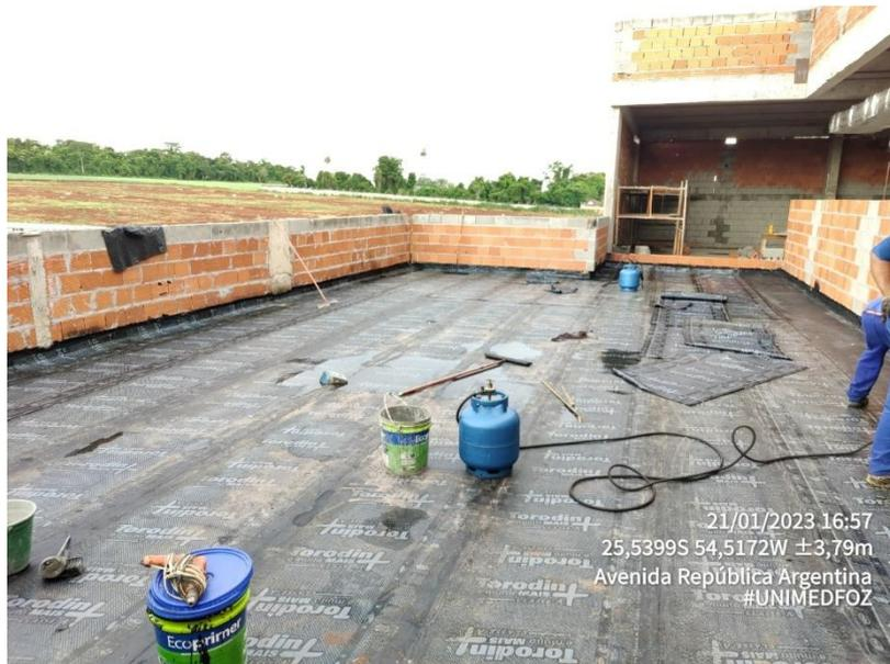
**Foto 18 – Impermeabilização – Cobertura – Manta Poliéster**
