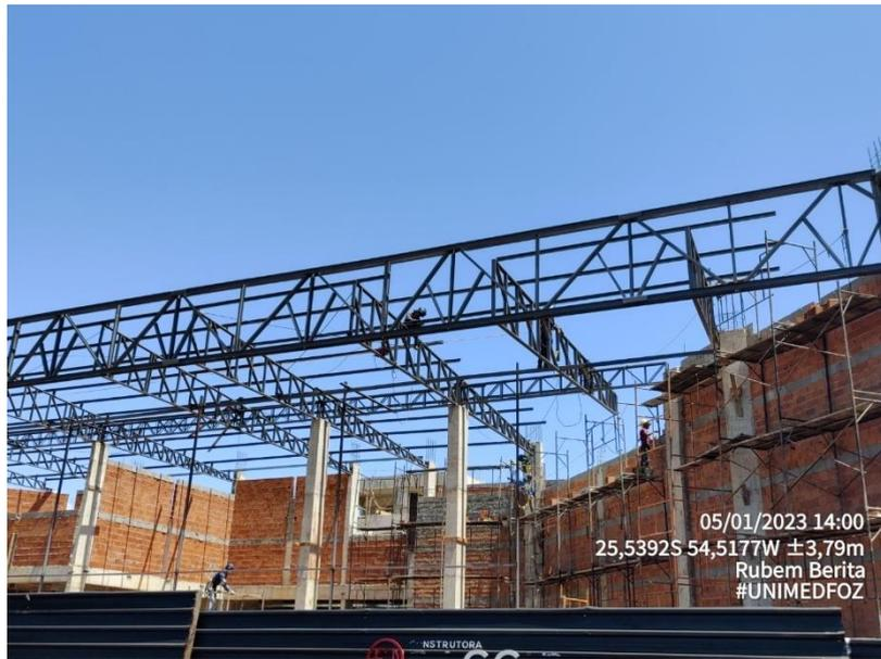
**Foto 1** – Estrutura Metálica + Cobertura– Fachada Principal
