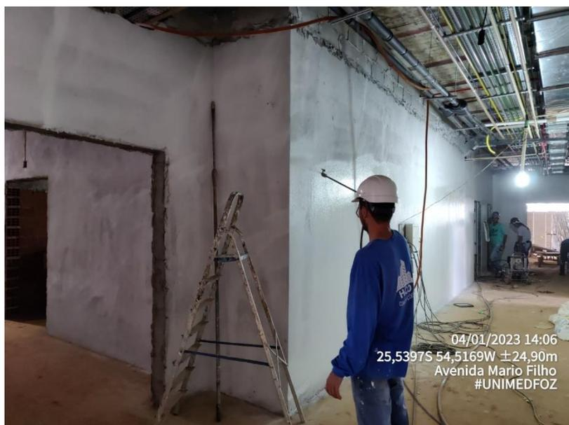
**Foto 10 – Pintura – Aplicação de Selador – Trecho 01/02**
