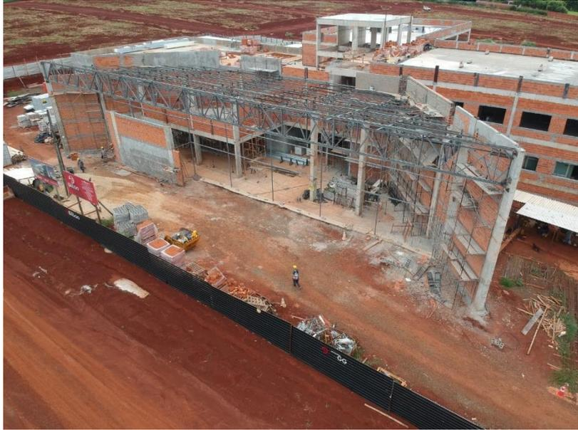
**Foto 3 – Estrutura Metálica + Cobertura– Fachada Principal**
